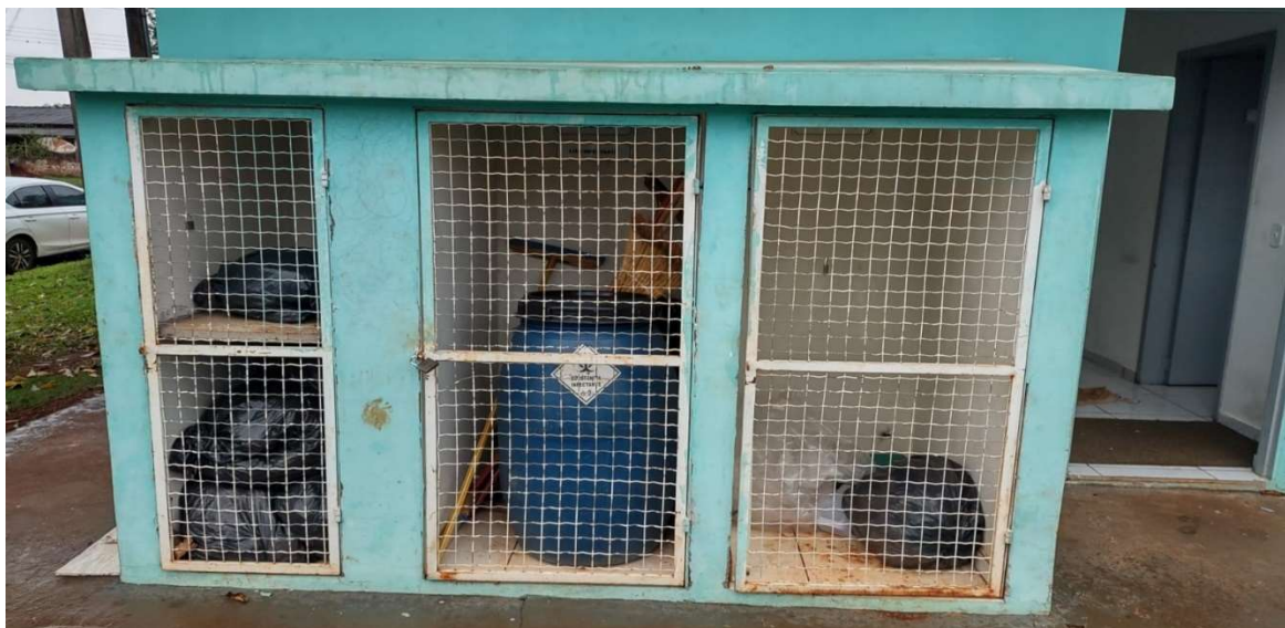
Figura 34 - Edificação específica de armazenamento temporário de resíduos dos serviços de saúde da UBS Jardim América do município de Vera Cruz do Oeste/PR
