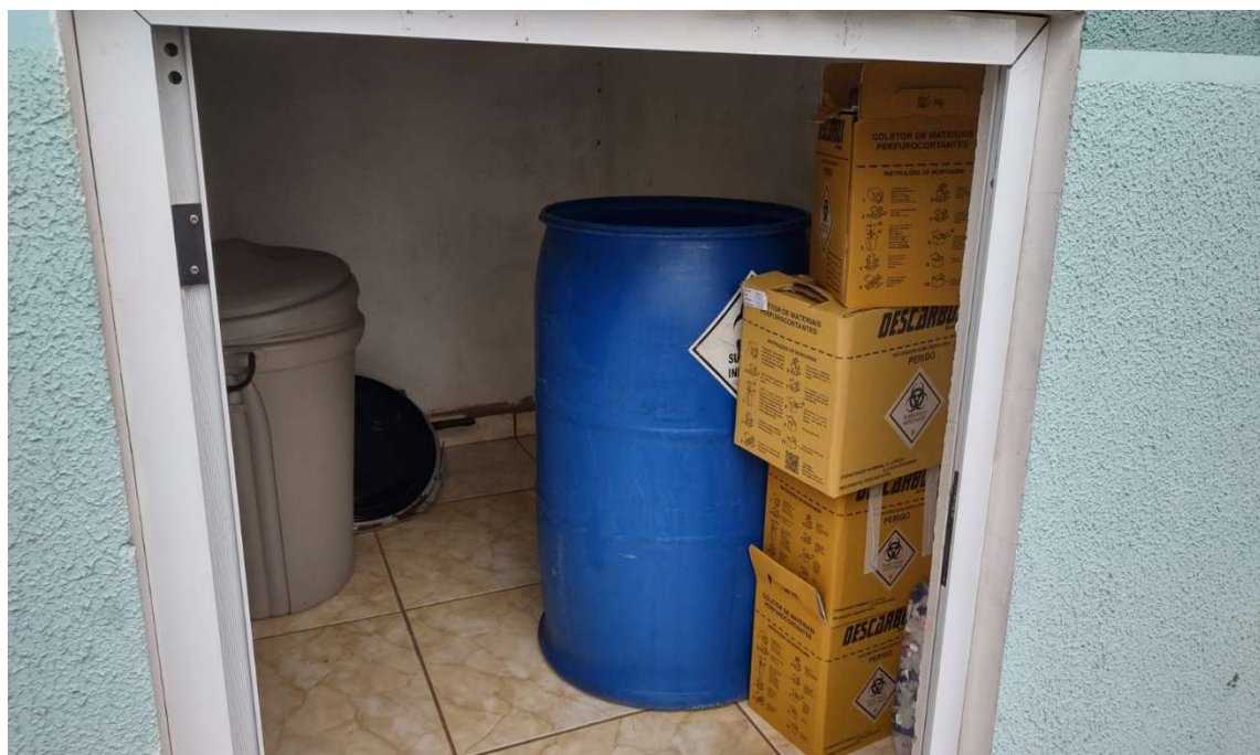
Figura 36 - Local de acondicionamento (Lixo Infectante) de resíduos de saúde na edificação específica da UBS Central do município de Vera Cruz do Oeste/PR
