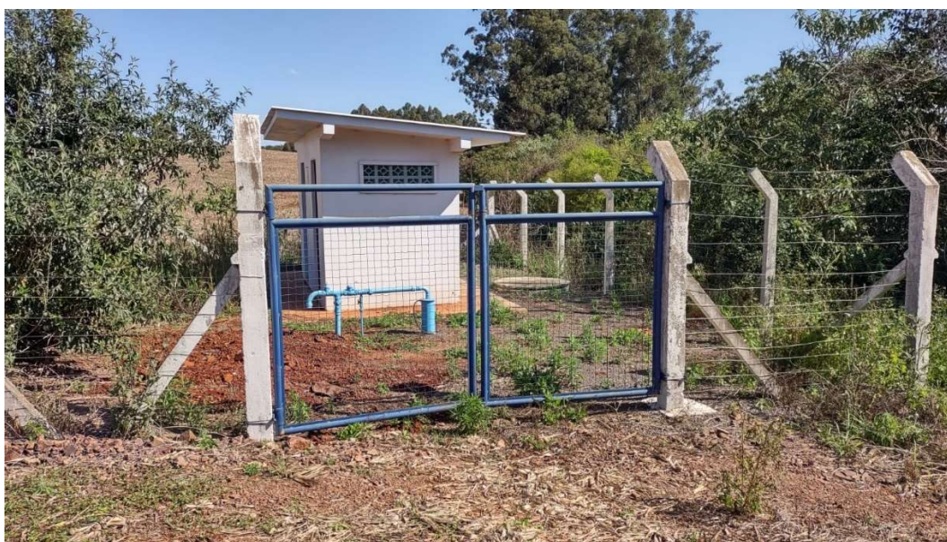
Figura 5 - Visão lateral do sistema de captação de água da Comunidade Barro Preto.
