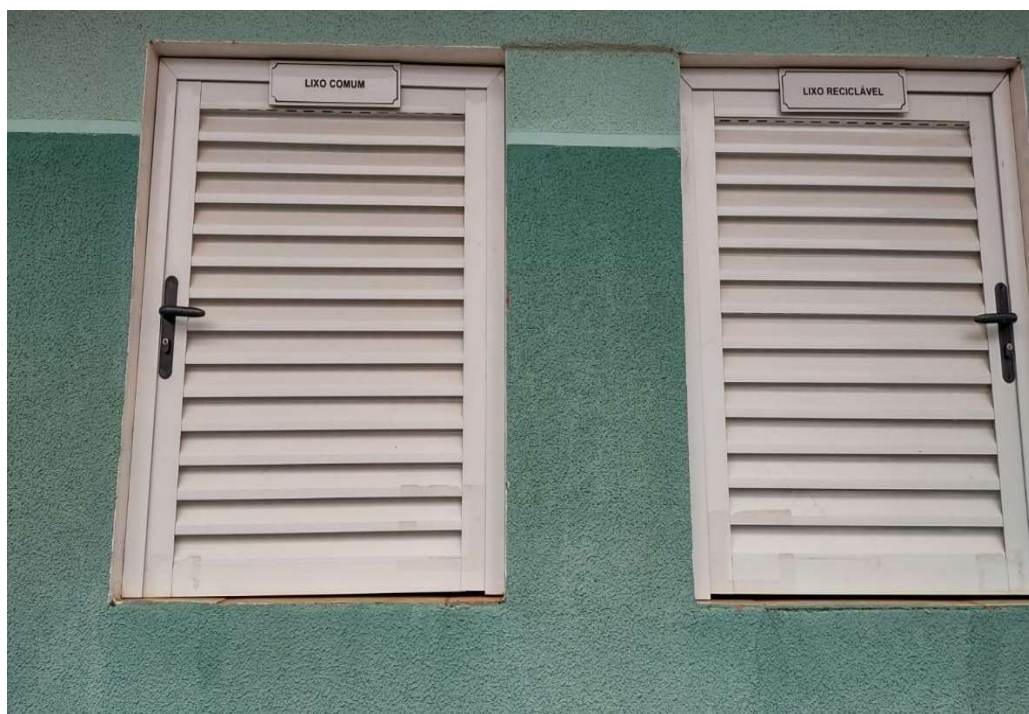
Figura 35 - Edificação específica de armazenamento temporário de resíduos dos serviços de Saúde da UBS Centro do município de Vera Cruz do Oeste/PR
