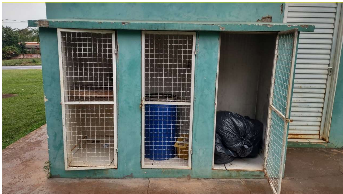
Figura 39 - Edificação específica de armazenamento temporário de resíduos dos serviços de saúde da UBS Jardim Bandeirantes do município de Vera Cruz do Oeste/PR
