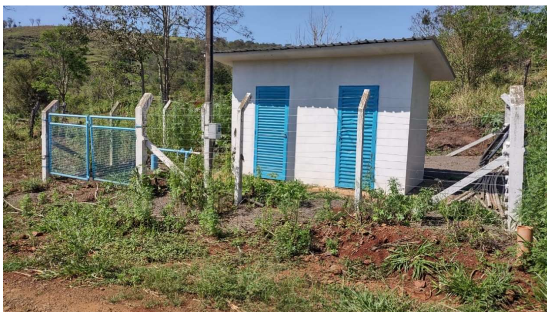
Figura 8 - Sistema de captação de água da Assentamento e comunidade Ander Henrique Rodolfo
